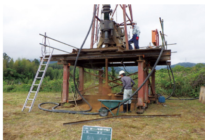
鑿井工事の様子
