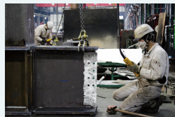
建築鉄骨の製作の様子
