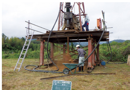
鑿井工事の様子
