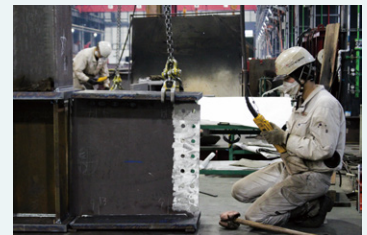
建築鉄骨の製作の様子
