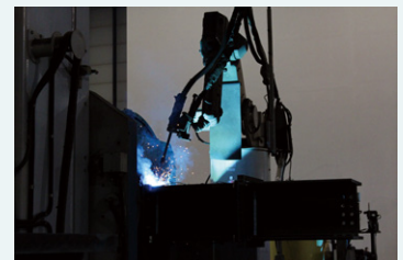
ロボット溶接の様子
